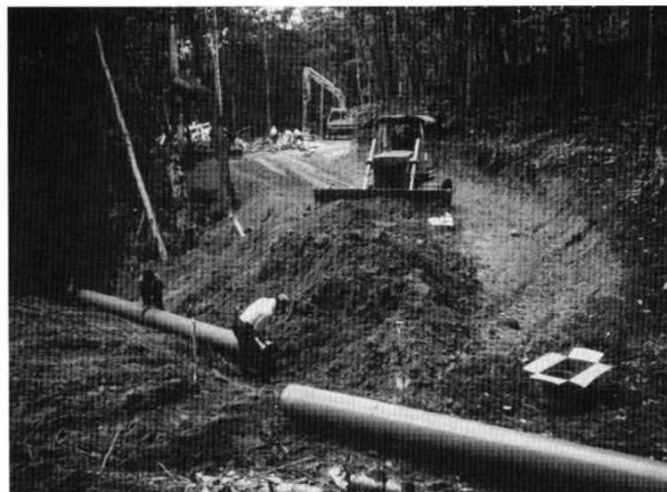
林道作設作業、排水管を埋めている
